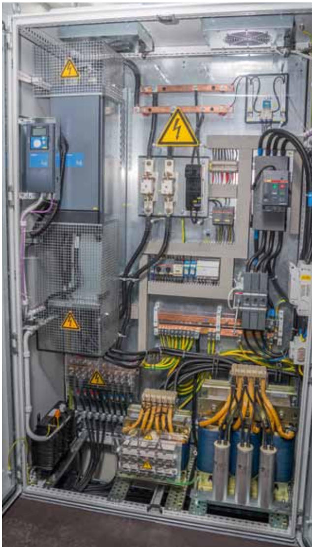
Steuerschrank mit Leistungselektronik. Diese Schränke werden meist in einem zweiten Raum im Speichercontainer untergebracht.
