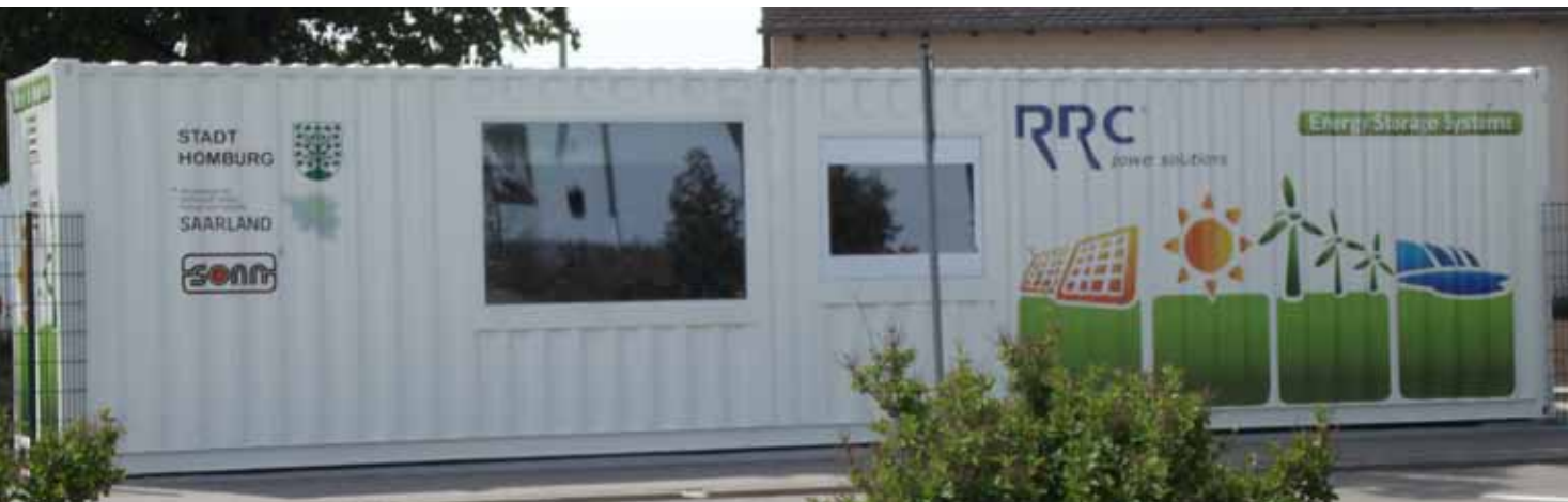
Speicheranlage am Baubetriebshof in Homburg mit 380 kW Photovoltaik, 280 kWh / 100 kW Speichersystem, 300 MWh Jahresbedarf.
